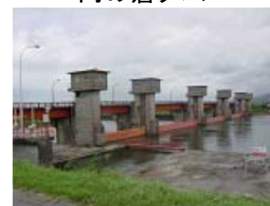
加治川第2頭首工
