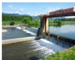
加治川第1頭首工
