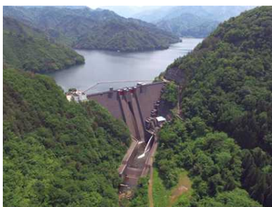
内の倉ダム(改修後)
