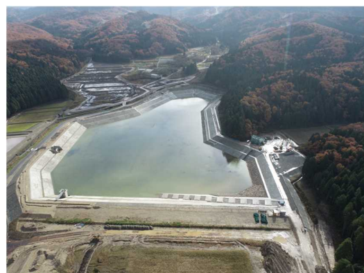
松岡ため池（新設後）
