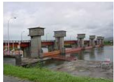
加治川第2頭首工
