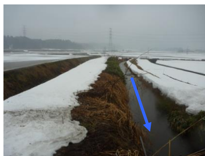
魚巢ブロック設置区間（改修前）
