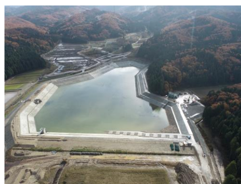
松岡ため池（新設後）
