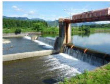
加治川第1頭首工
