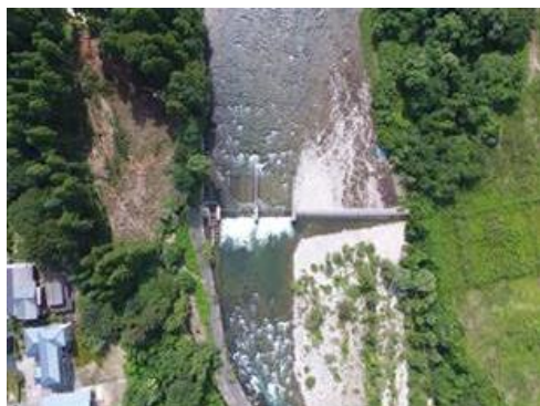
加治川右岸頭首工（改修前）
