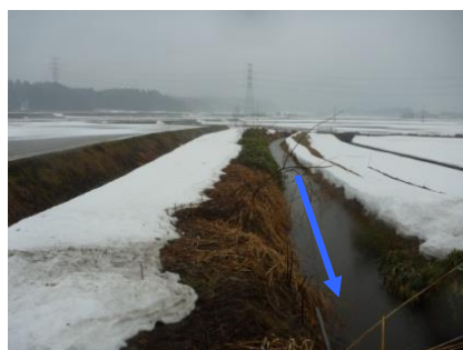
魚巢ブロック設置区間（改修前）
