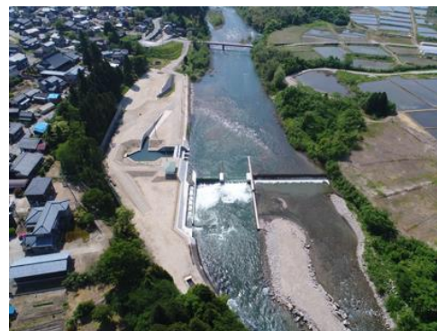
加治川右岸頭首工（改修後）
