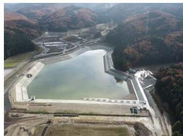
松岡ため池（改修後）
