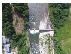
加治川右岸頭首工（改修前）
