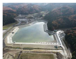
松岡ため池（新設後）
