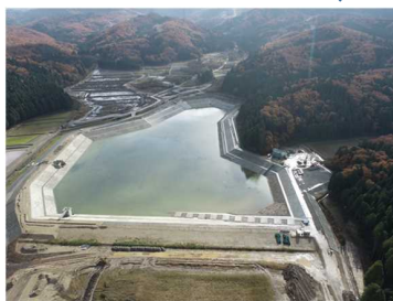
松岡ため池 (新設後)
