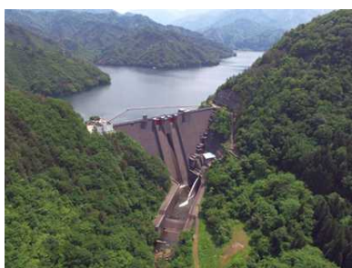
内の倉ダム(改修後)
