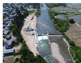
加治川右岸頭首工（改修後）
