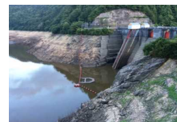
内の倉ダムの渇水状況 （平成30年）
