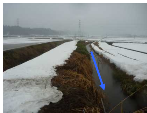
魚巣ブロック設置区間 (改修前)
