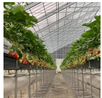
いちご狩りにも適した 高床ハウス
