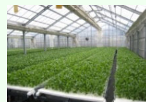
農業生産施設（水耕栽培ハウス）
