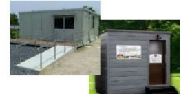
休憩所、トイレの整備
