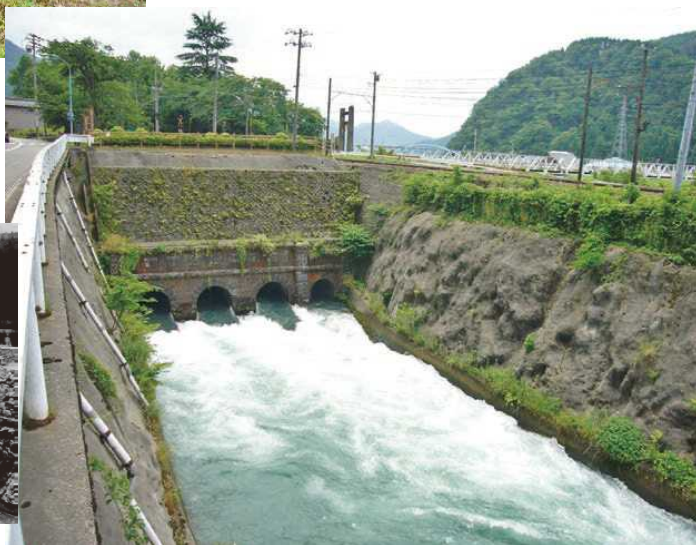
現在の給水口
