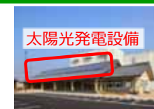
太陽光発電設備
