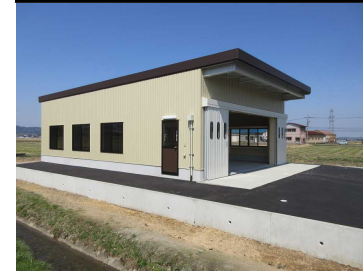
作業所の新設
