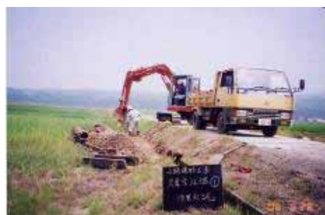
用水路の補修
