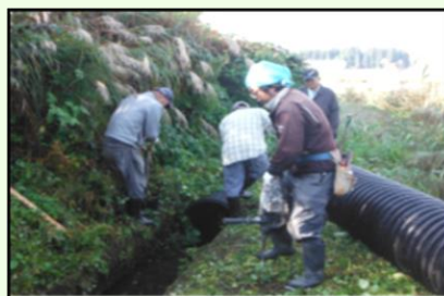
水路のコルゲートパイプ化 などによる漏水対策
