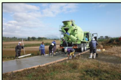
集落共同でのコンクリート 舗装作業
