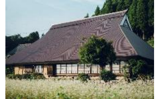
改修予定の古民家
