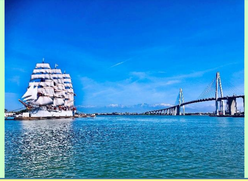
帆船海王丸と新湊大橋
