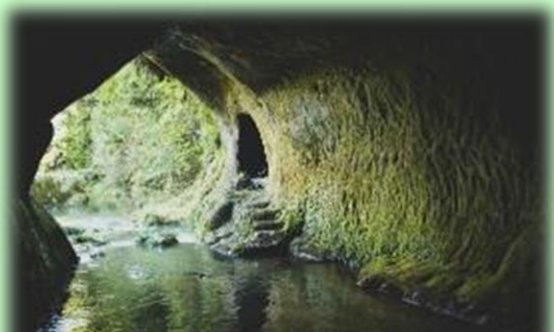
鉄砲ぐり（灌漑用水路）
