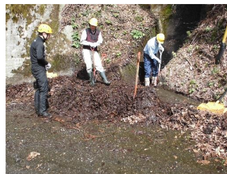
【水路補修の様子】
