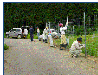
【耐雪型侵入防止柵の設置】
