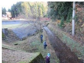
【電気柵の設置】
