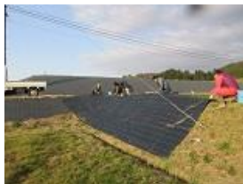
【防草シート張り】
