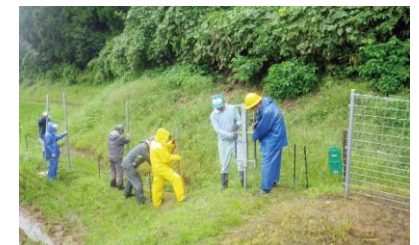
【耐雪型侵入防止柵の設置】
