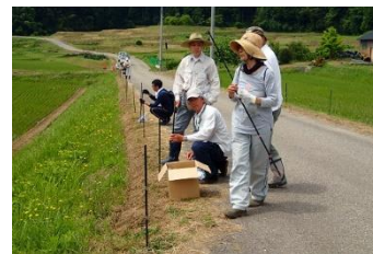
【ボランティアによる電気柵設置】
