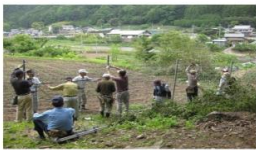
侵入防止柵の設置
