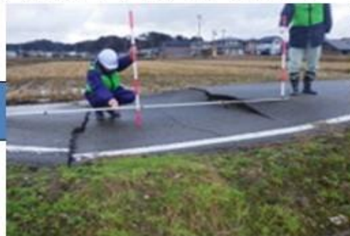
パイプライン埋設道路の被災状況調査及び埋設管破損状況
