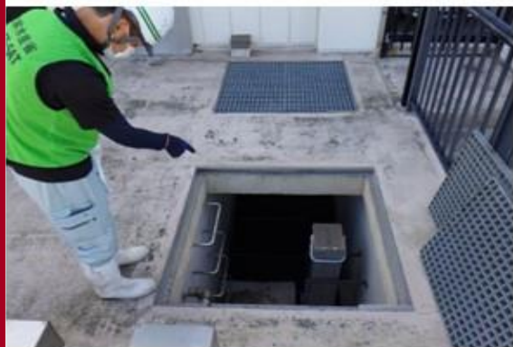
農業集落排水施設の点検(於輪島市)
