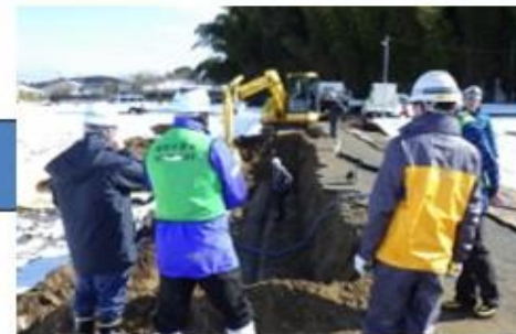
応急復旧作業の監督・立会
