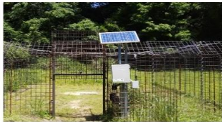
囲いわな設置状況
