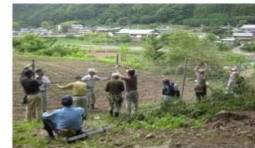
侵入防止柵の設置
