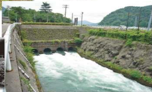
現在の給水口
