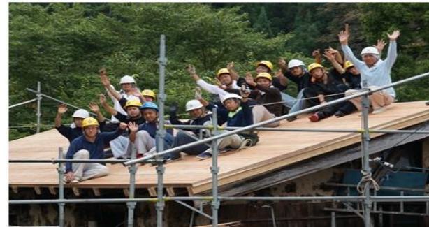
福井工大生による伝統的古民家の修復再生活動
