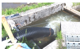
←仮設ポンプ設置 （珠洲市）
