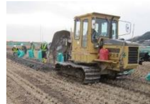
トレンチャ工法の施工状況
