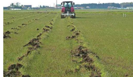
補助暗渠を施工している様子
