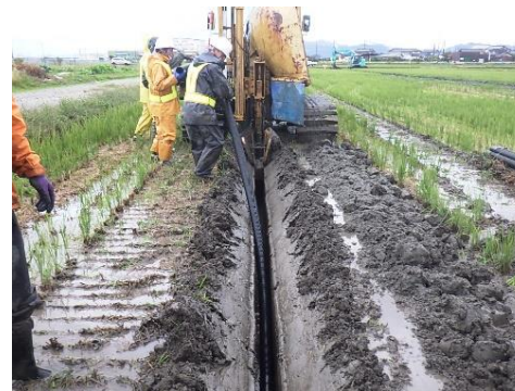
掘削及び管の設置
