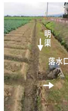
明渠と落水口の接続
