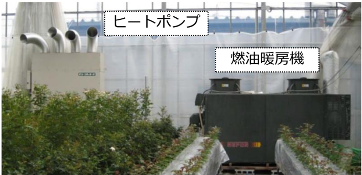
ヒートポンプと燃油暖房機のハイブリッド運転
