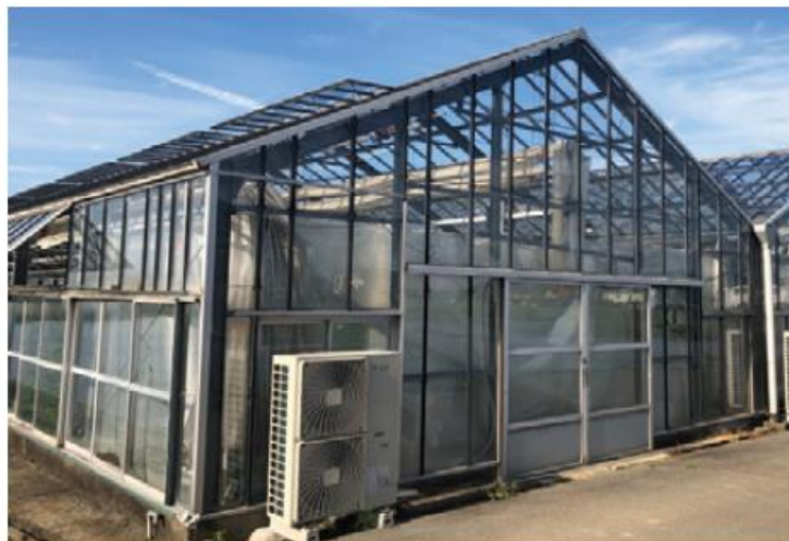
栽培用ハウス横に設置されているダイキンのヒートポンプエアコン
