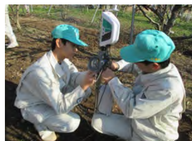
フィールドサーバ設置
