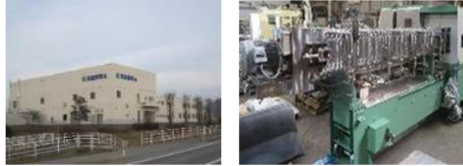
<製パン施設> <米粉製造機械>
