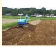
土層改良（客土）
