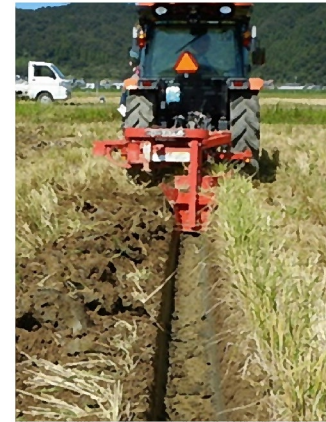
作溝作業の直進精度が向上（排水の改善）
