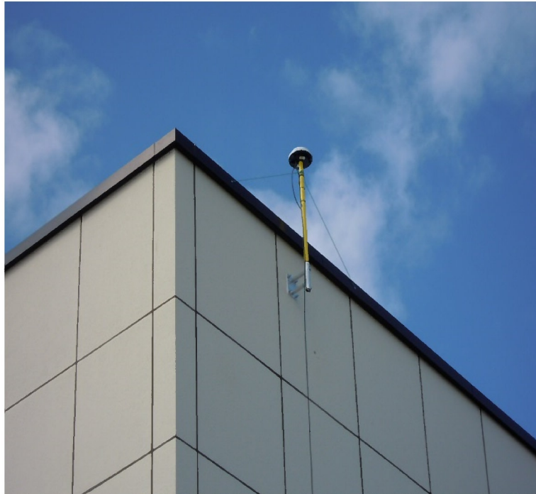
固定基地局GNSSアンテナ
