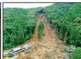
山腹崩壊の状況
