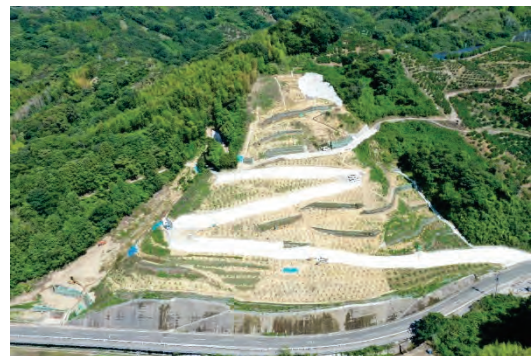
復旧の様子（令和4年7月）
