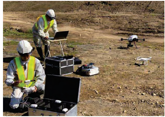
UAV作業風景
