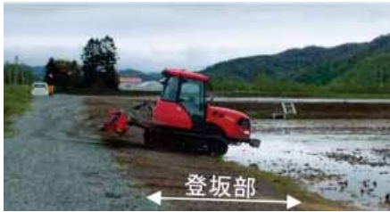
ターン農道の整備
