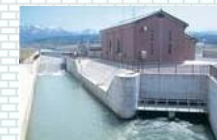
小水力発電施設
