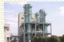
バイオエタノール製造施設
