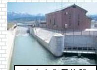
小水力発電施設
