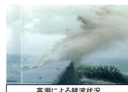
高潮による越波状況
