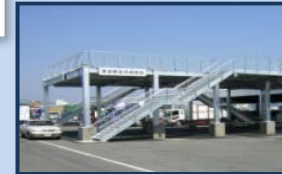
津波避難施設
