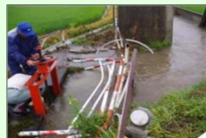
異常気象等後の 見回り・応急措置
