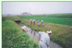
水路の泥上げ (日常の管理)
