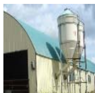
飼料保管タンク
