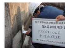
水路の機能診断
