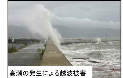
【海岸保全施設整備】
