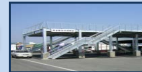
津波避難施設
