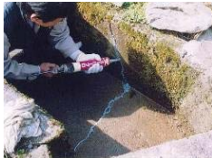
水路のひび割れ補修
