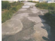
農道の窪みの補修
