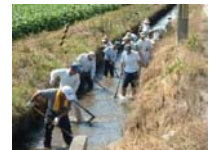
水路の泥上げ
