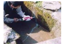
水路のひび割れ補修
