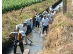
水路の泥上げ
