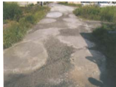
農道の窪みの補修
