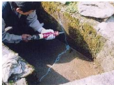
水路のひび割れ補修
