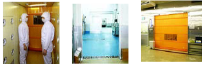
エアシャワー 床面 ゾーンシャッター
