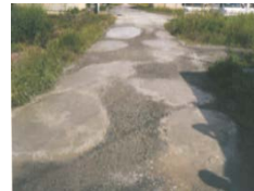
農道の窪みの補修
