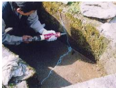
水路のひび割れ補修
