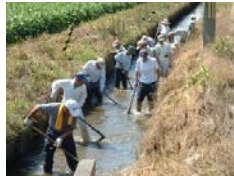
水路の泥上げ
