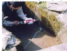
水路のひび割れ補修
