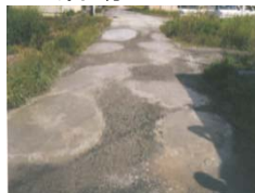
農道の窪みの補修
